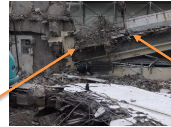
【建物崩壊現場】
